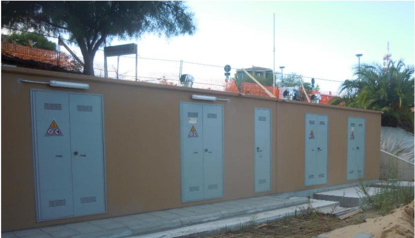
Figura 1: cabina di consegna fornitura energia elettrica in media tensione
