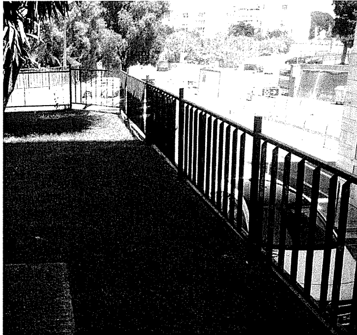
Figura 3- (FT1)Parapetto zona box gas tecnici zona laboratori
